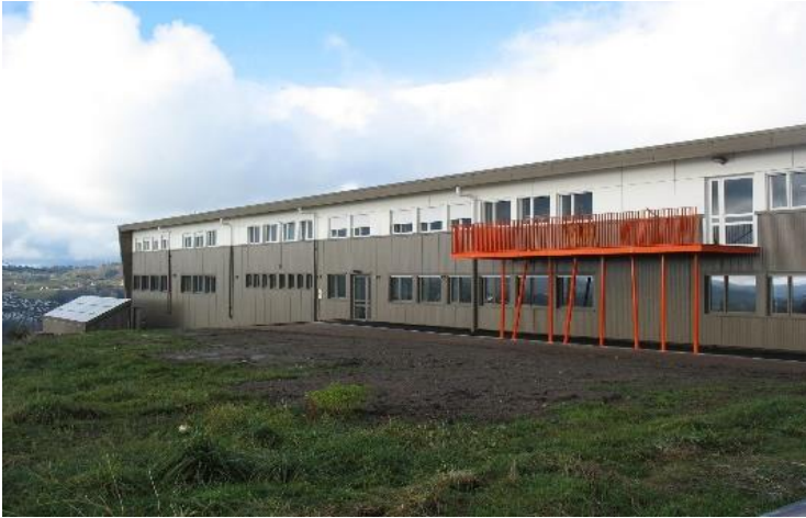
CFA Bâtiment Tulle, les ateliers
